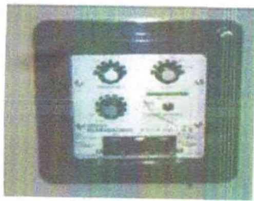
過電流継電器 (OCR)
